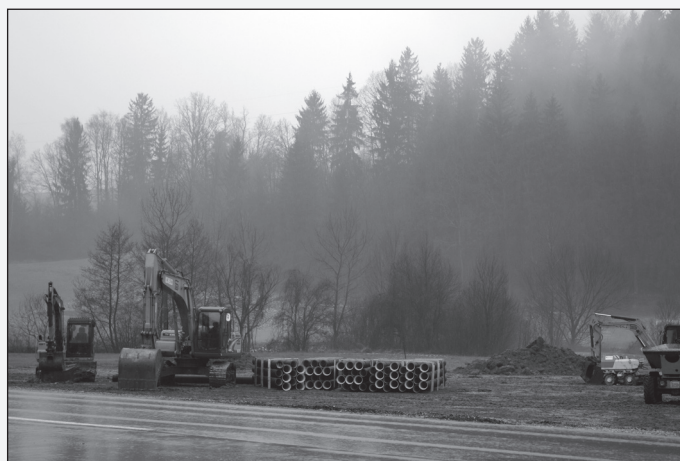
Na gradbišču v Lokarjah
